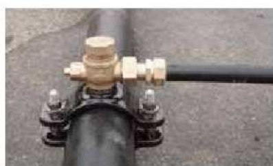
(4) 給水管取付 (ポリエチレン二層管)
