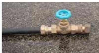
(5) 止水栓の取付
