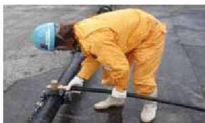
(4) 給水管取付 (ポリエチレン二層管)
