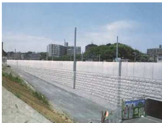
壁面・補強盛土 施工完了
