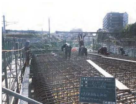
鉄筋・型枠
