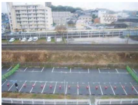
推進中（発進立坑）
