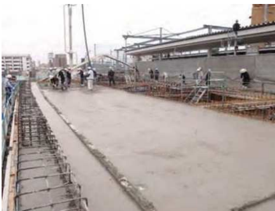
梁・スラブ コンクリート打設
