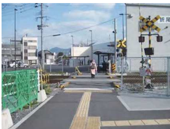
日吉町踏切 除却前
