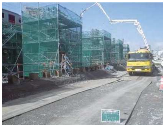
柱 コンクリート打設
