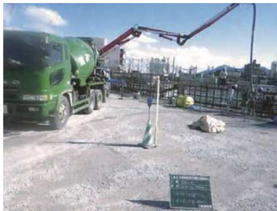
壁面 コンクリート打設
