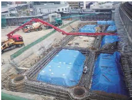
基礎梁 コンクリート打設
