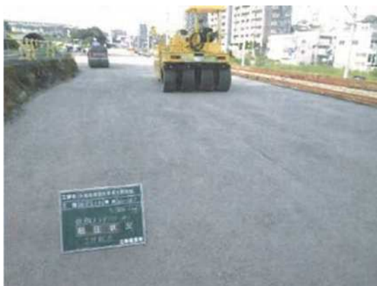
補強盛土 転圧
