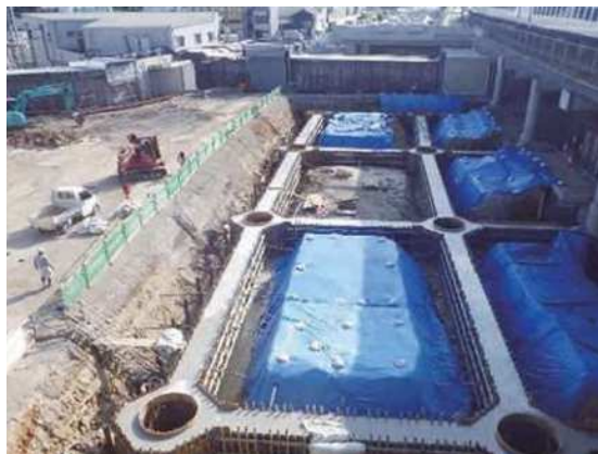
基礎梁 施工完了
