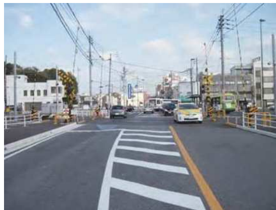
国道踏切 除却前
