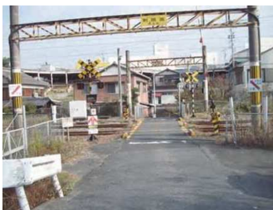
大膳第1踏切 除却前
