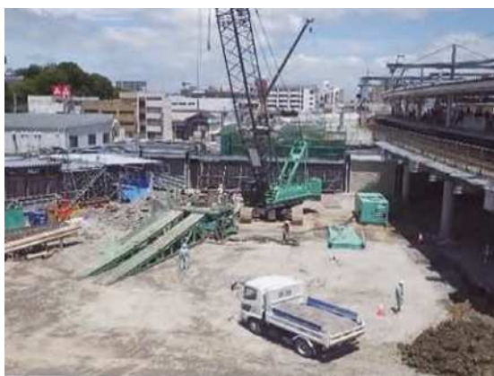
場所打ち杭 掘削
