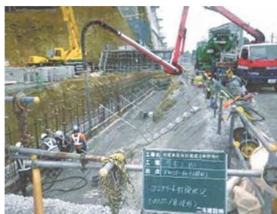
壁面基礎 コンクリート打設
