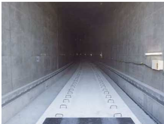
路盤コンクリート
