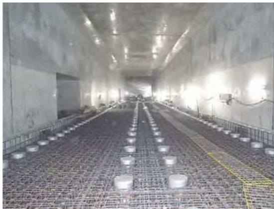
コイルパネ・鉄筋組立完了
