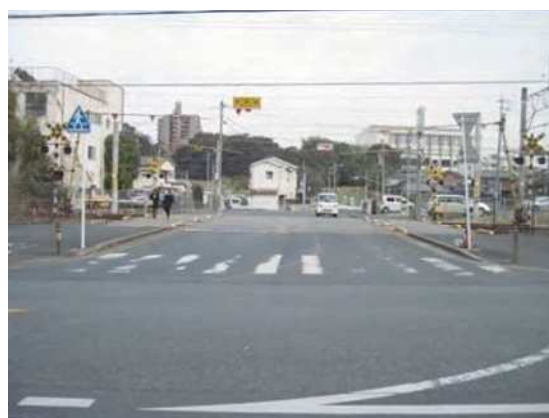
天神町踏切 除却前
