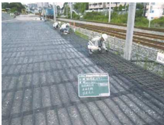
補強盛土 面状補強材
