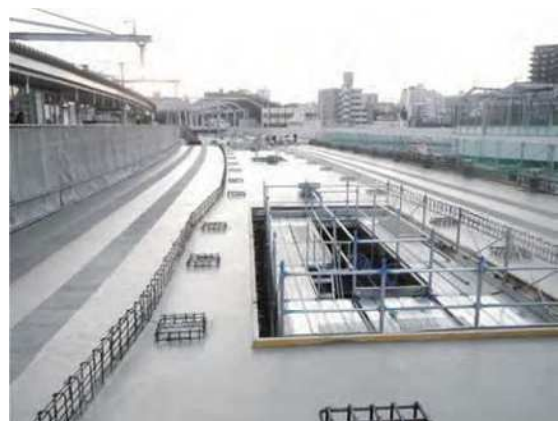
梁・スラブコンクリート
