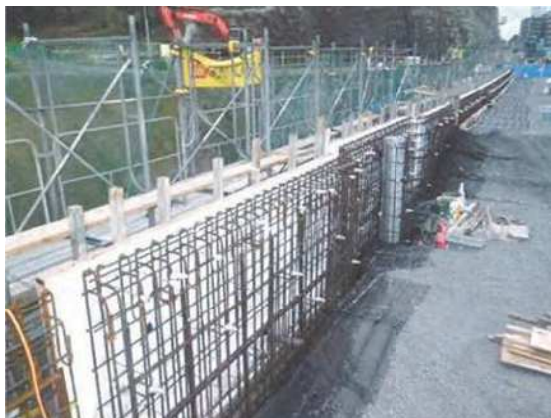
壁面 型枠・鉄筋
