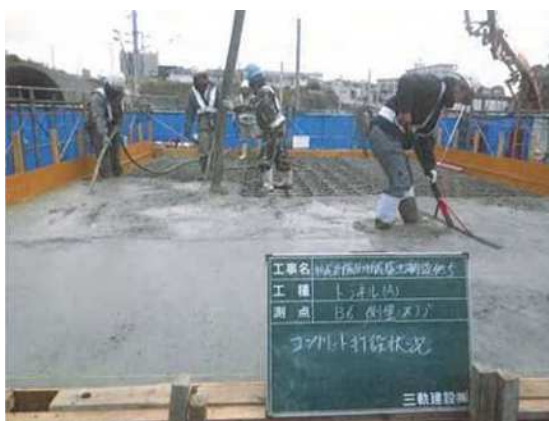
コンクリート打設
