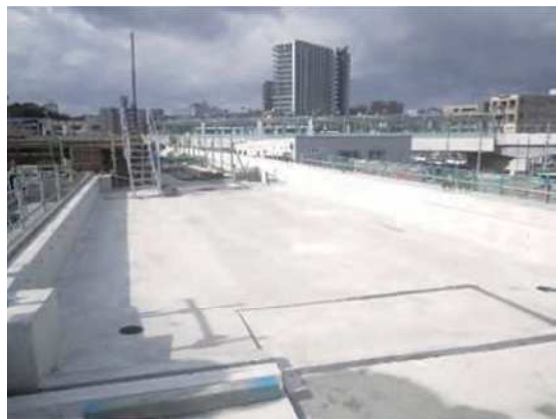
施工完了（橋面）
