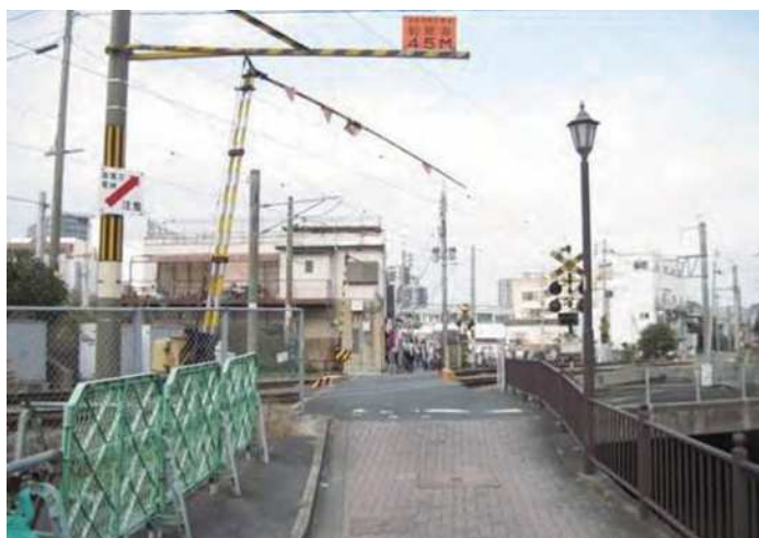
川端通り踏切 除却前
