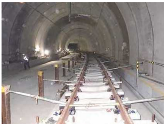
軌きょう組立完了
