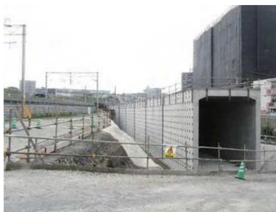
トンネル 施工完了
