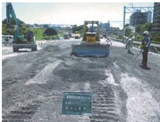
補強盛土 敷均し
