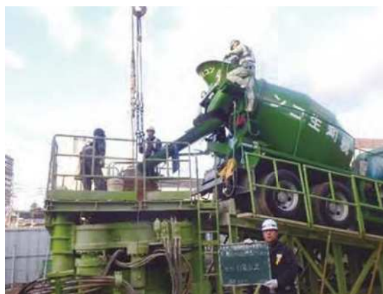
場所打ち杭 コンクリート打設
