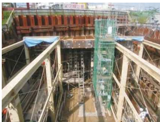
推進中（発進側立坑）
