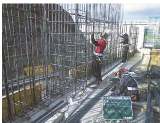
壁面 鉄筋組立
