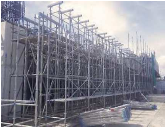
支保工足場仮設
