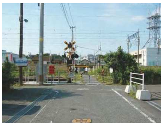
鷹見踏切 除却前
