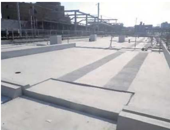
施工完了（橋面）
