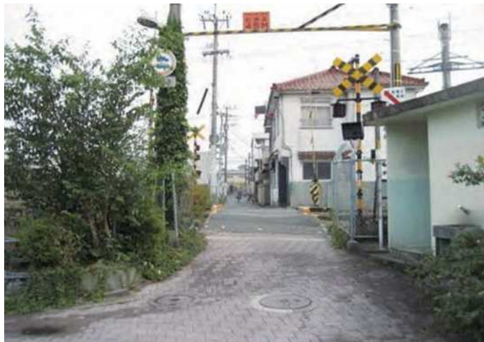
四反田踏切 除却前
