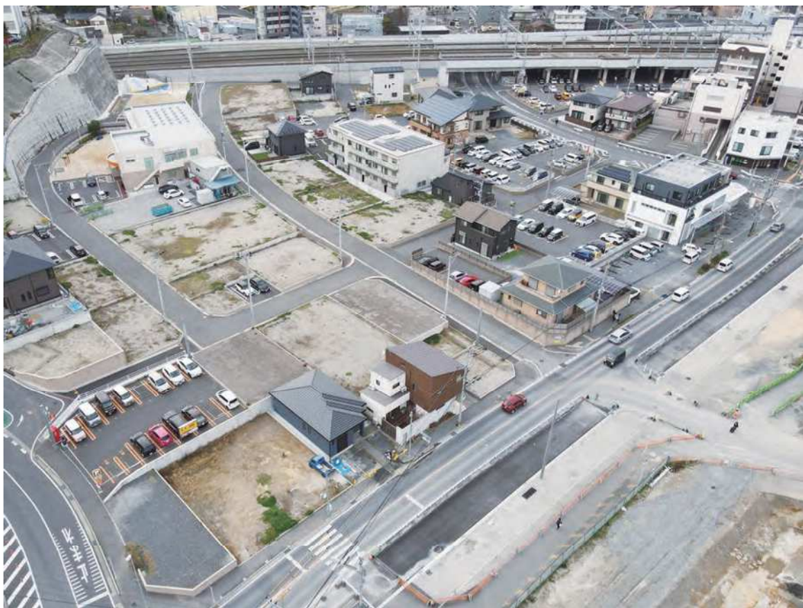
堀川町地区宅地造成後
