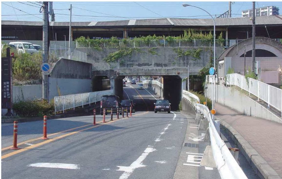
折尾中間線 アンダーパス
