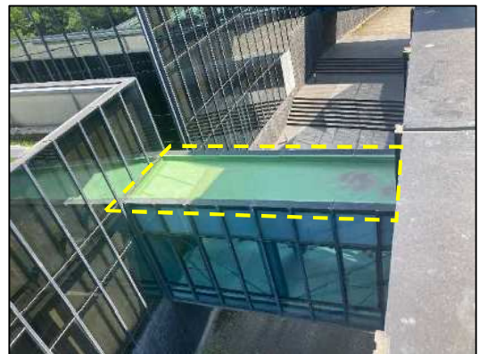
<生涯学習センター側通路>
