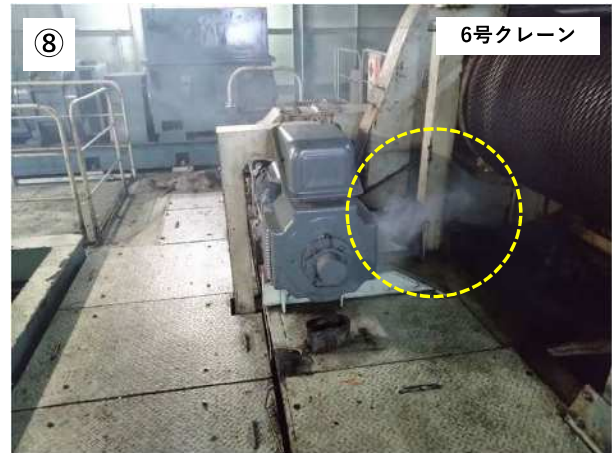
起伏電動機発煙
