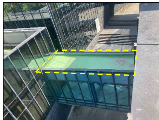
<生涯学習センター側通路>
