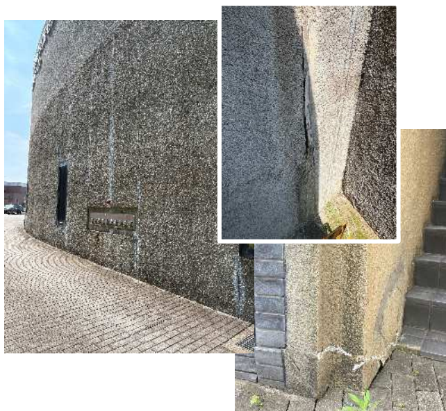
外壁に多くのひび割れが発生
