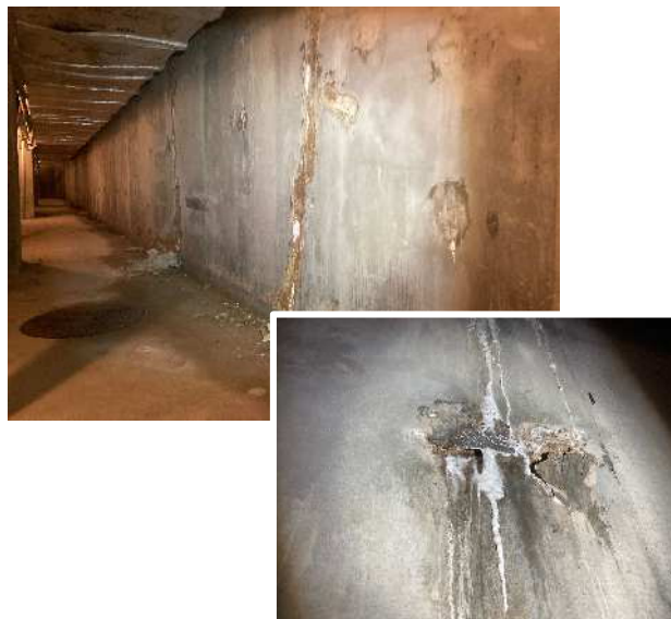
湧き水が壁から染み出てきて、コンクリートが剥離
