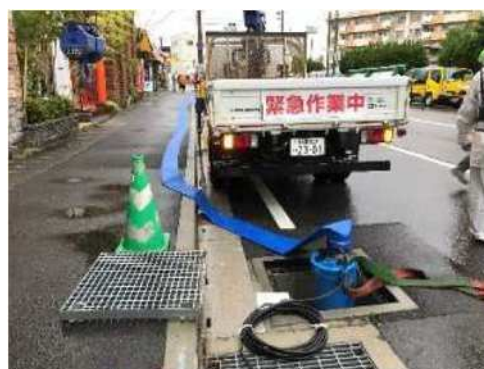
仮設排水ポンプの設置（豪雨対策）
