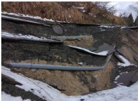
水道の送水管の被災
