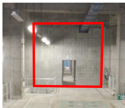
補強後（中空部に耐震壁を設置）
