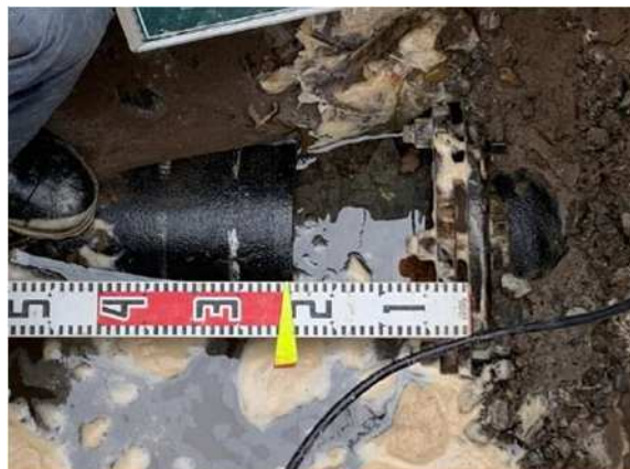
下水道の圧送管の被災
