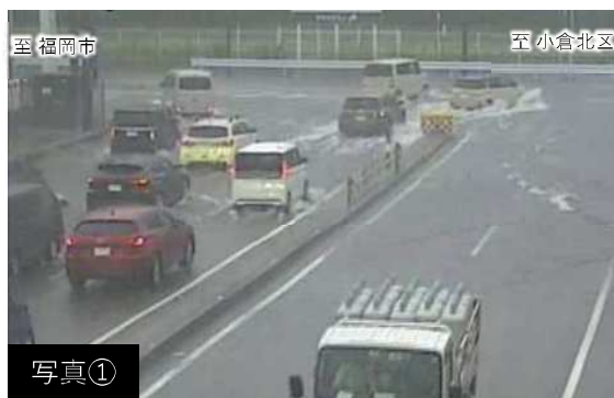
▲ 前田ランプ入口における冠水状況 (R7.8)
