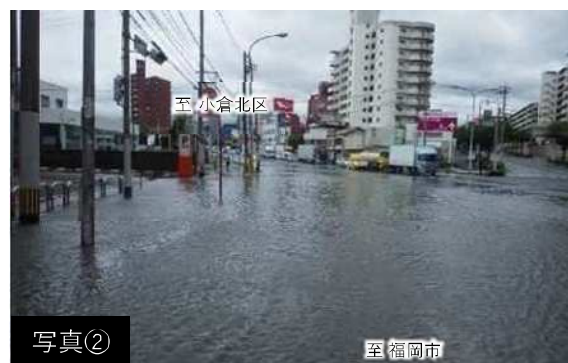
▲ 国道3号桃園2丁目交差点付近での冠水状況 (H27.8)
