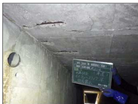
No.2～No.3区間 欠損、鉄筋露出
