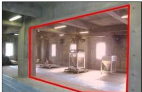
補強前（耐震診断により補強箇所を選定）
