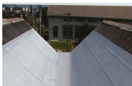
ポンプ棟屋上防水後
