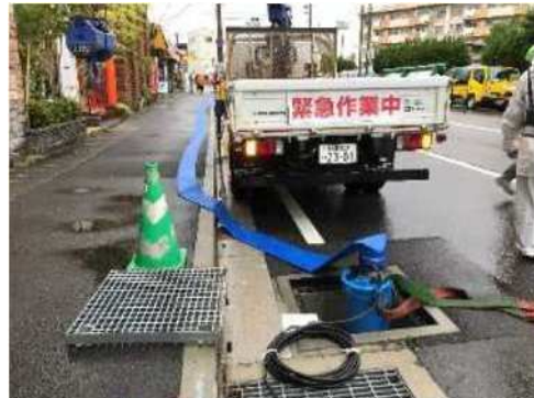
仮設排水ポンプの設置（豪雨対策）
