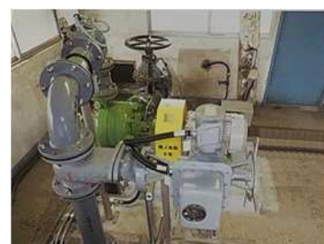
ポンプ設備更新後
