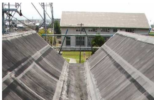
ポンプ棟屋上防水前
