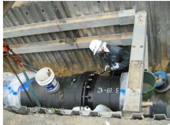
耐震管布設状況
