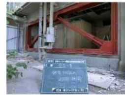
看護師宿舍棟耐震補強工事
