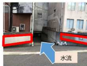
止水板の設置
