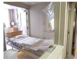
陰圧個室内へのベッド搬入時の様子 (奥が病室)
