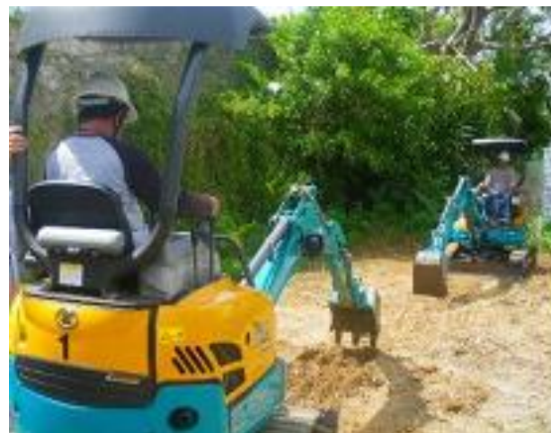
ICT建機の活用
