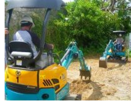
ICT建機の活用
