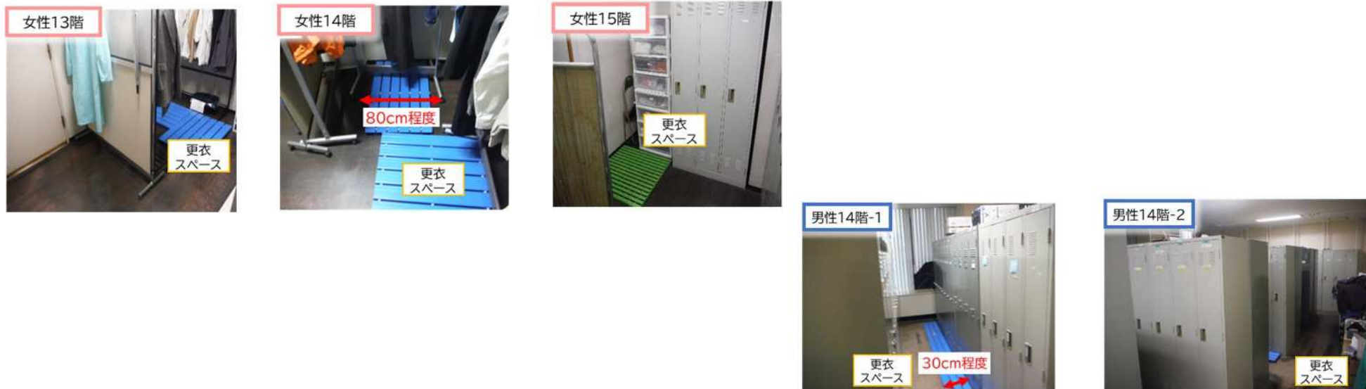
写真2-1 現状の更衣室
