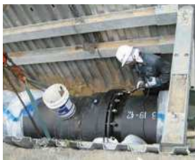
耐震管の布設状況(水道)
