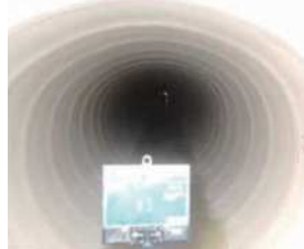
管渠の内部を全面補強(下水道)
