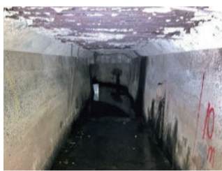
腐食により劣化した下水道管
