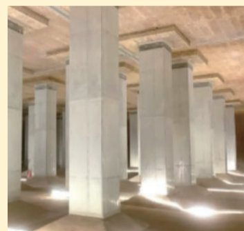
完了(柱の補強)
