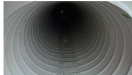
既存の管の内側に新たな管を構築
