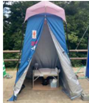
災害用マンホールトイレ
