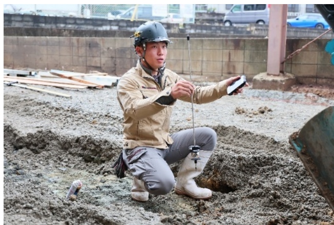
ICT機器を用いた測量
