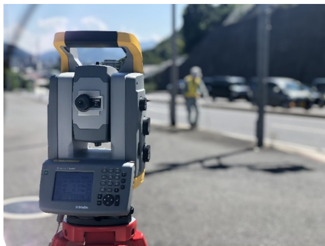
測量作業風景
