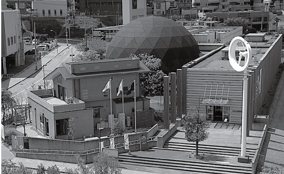
風レンズ風車や壁面緑化、太陽光発電など環境配慮設備を取り入れている環境ミュージアムと北九州エコハウス
