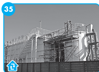
35 ウォータープラザ北九州 小倉北区西港町96-1(日明浄化センター内) ☎(093)562-3271
