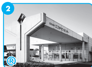
2 エコタウンセンター 若松区向洋町10-20 ☎(093)752-2881
