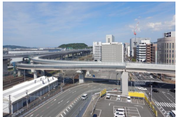
▲黒崎西ランプ（筒井町交差点）の状況（R8.6）
