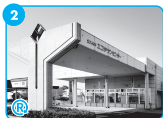
2 エコタウンセンター 若松区向洋町10-20 ☎(093)752-2881
