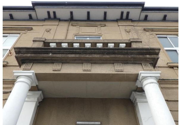
2階バルコニー廻り
