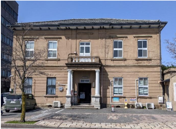
石炭会館 全景
