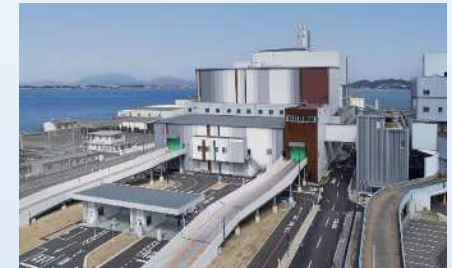
ごみ焼却工場(日明工場)
