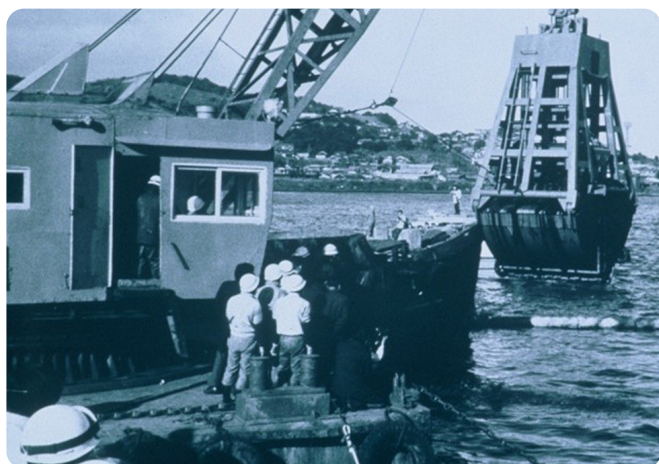
洞海湾のヘドロを取り除く
