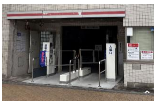
＜西小倉駅前自転車駐車場＞ 自動入出庫機器（自動ゲート）
