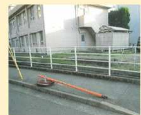
カーブミラーの倒壊
