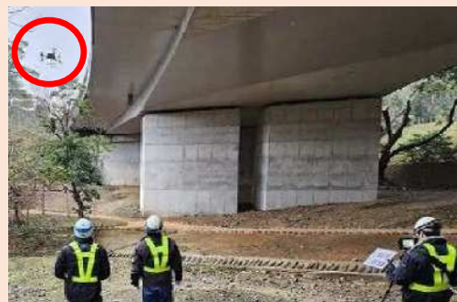
ドローンによる点検
