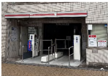
自動入出庫機器（自動ゲート）の導入例
