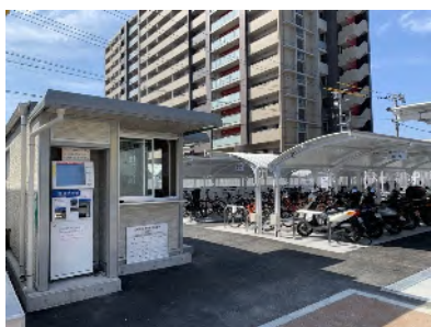
＜八幡駅前自転車駐車場＞
