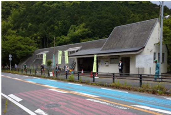
＜河内サイクリングセンター＞
