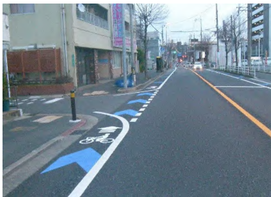
車道混在の整備例
