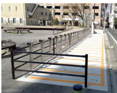
＜堺町地区の駐輪施設＞
