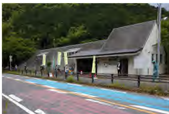
＜河内サイクリングセンター＞
