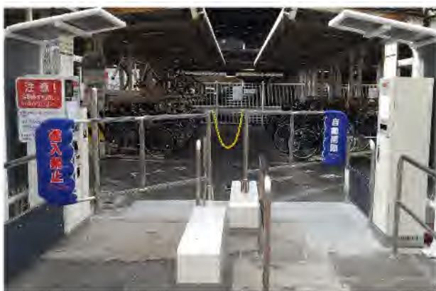
自動入出庫機器（自動ゲート）の導入例
