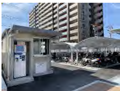
＜八幡駅前自転車駐車場＞
