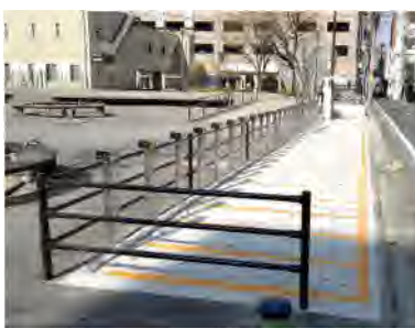
＜堺町地区の駐輪施設＞
