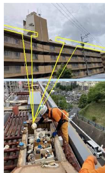
検針困難箇所
