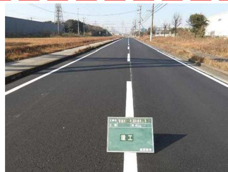
改修工事完了後(令和7年度実績)
