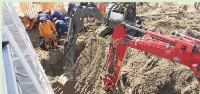
被災地での活動状況(平成30年7月豪雨)
