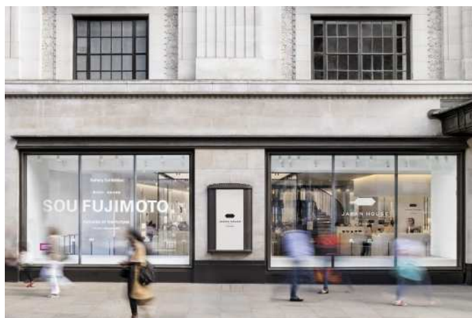
ジャパン・ハウス・ロンドン外観
