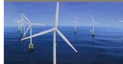
洋上風力発電関連事業
