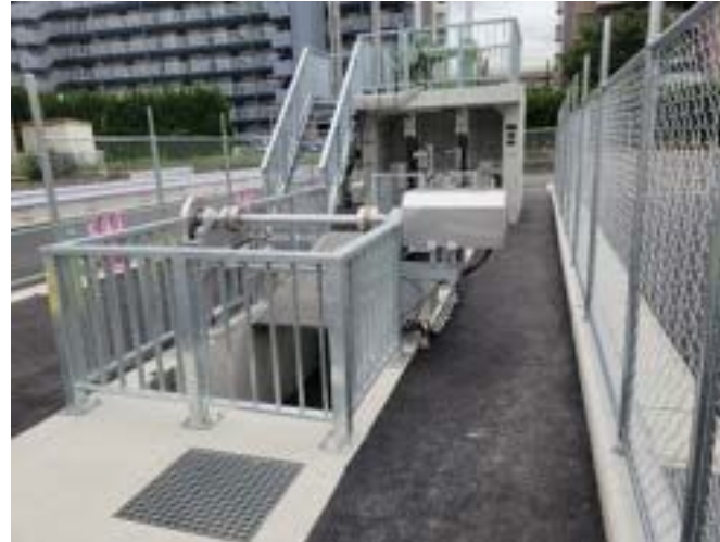
浸水対策整備工事(雨水排水ポンプ他機械設備工事)
