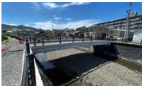
橋梁架け替え(相割川)
