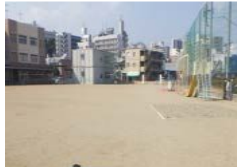
グラウンド改修工事(清水小学校)
