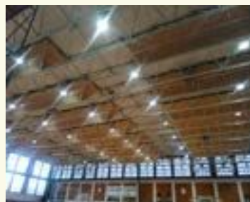
LED照明化工事
