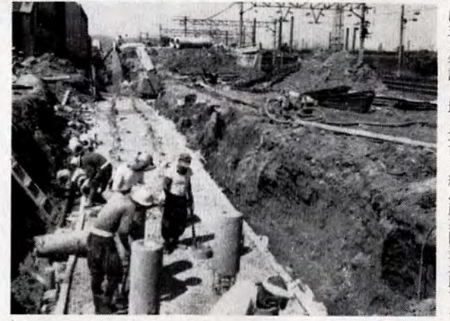
写真は…国道199号線戸畑区中原付近の工事現場、ここの工事が完成すると、小倉から若戸大橋まで一直線に結ばれます。
