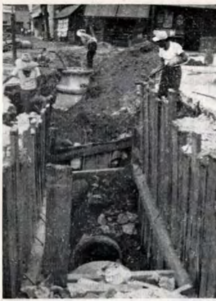
浅生通りロータリー跡付近での下水道工事
