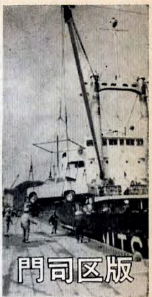
田野浦港の荷上げ風景
