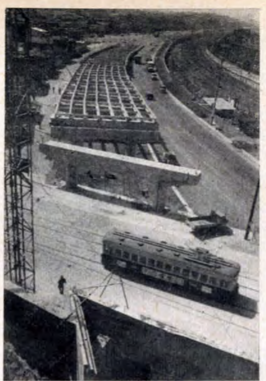
秋に完成をめざす八幡中央町の高架橋工事
