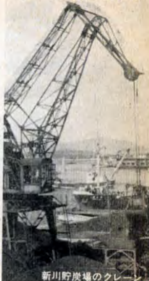
新川貯炭場のクレーン
