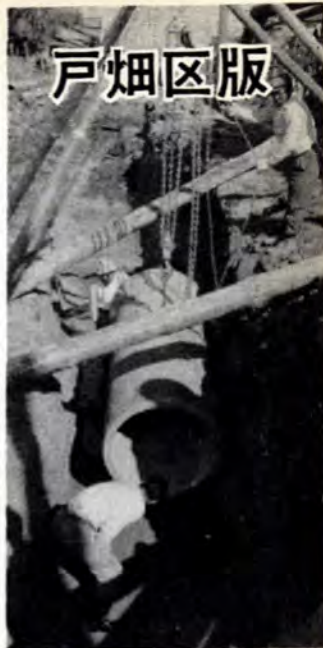
衛生都市へ…下水道管の埋設
