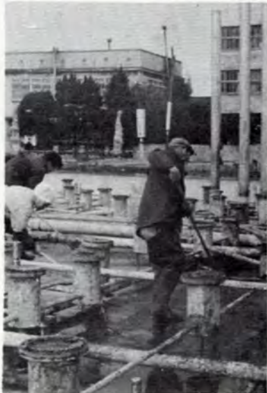
心ない人が、投げ入れたビンや石ころを除いて、美しい噴水に...
