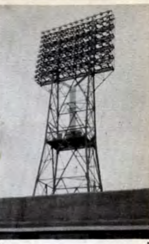
小倉球場の照明灯
