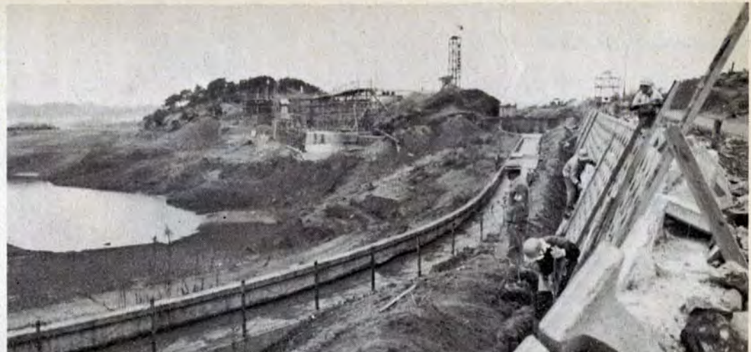
水を干して工事中の屯田第一貯水池
