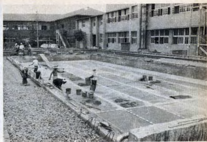
学校プールはシーズンに備えて工事中 (若松区高塔中学校)
