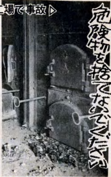
西港清掃工場の焼却炉
