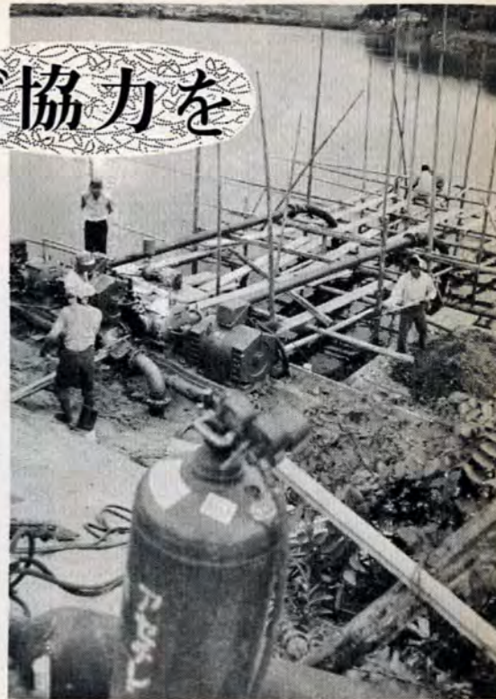
中間市切島池にポンプを設置し、ここから1日3千トン
