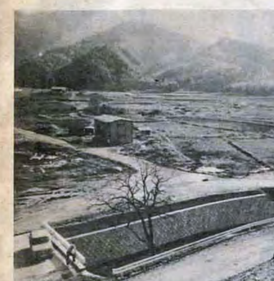
第3期拡張工事で新設する油木・ます湖の両ダムの水を浄化して、小倉、門司両区へ送る井手浦浄水場は、もっか整地工事中。
